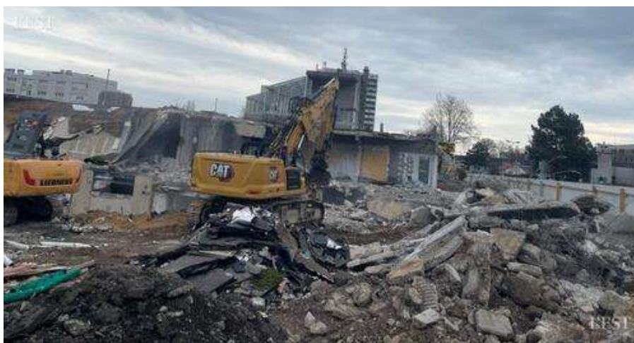
Une démolition qui s'inscrit dans le cadre de l'acte II du programme de rénovation urbaine. Photo F. B.
